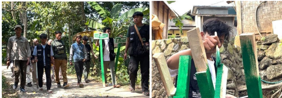
Gambar 4. Proses Pembuatan dan Pemasangan Papan Himbauan
