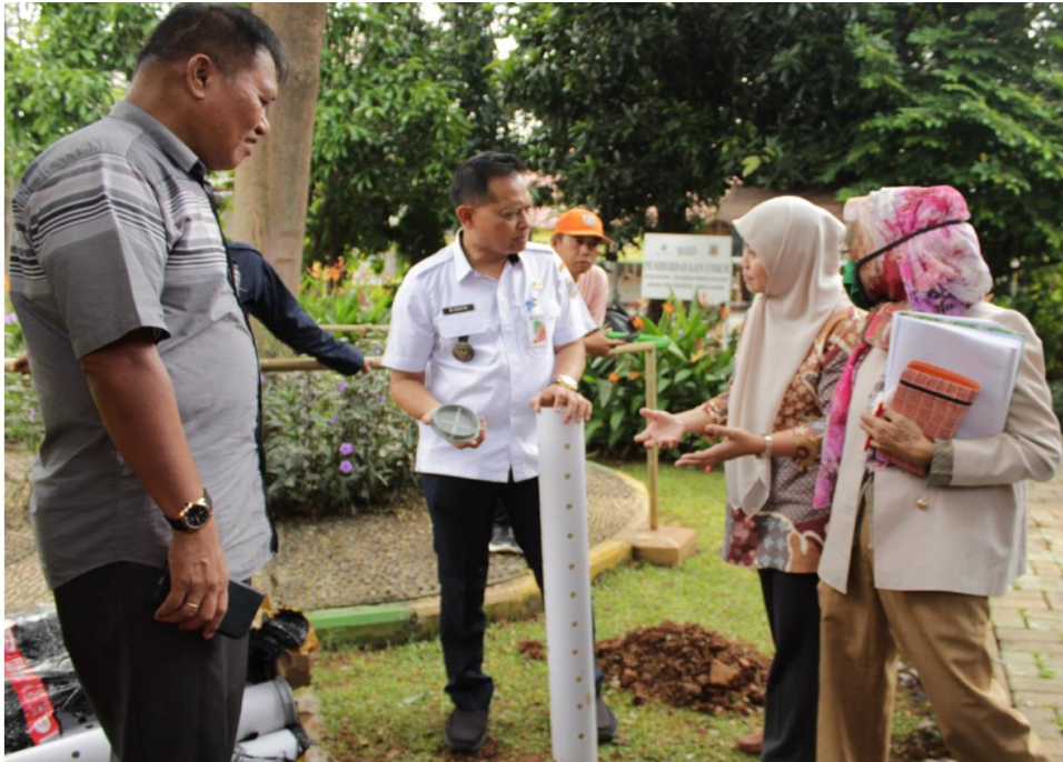
Gambar 3. Kegiatan Pemasangan biopori (3)
