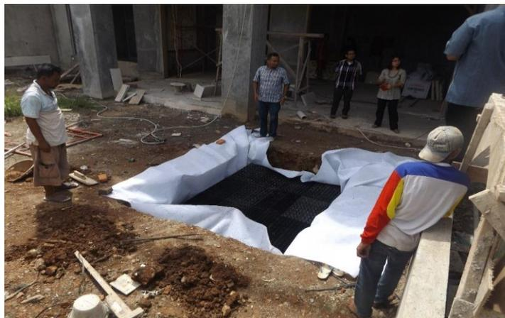
Gambar 2 Pemasangan Sumur Resapan Menggunakan Modular Tank di Pekarangan
