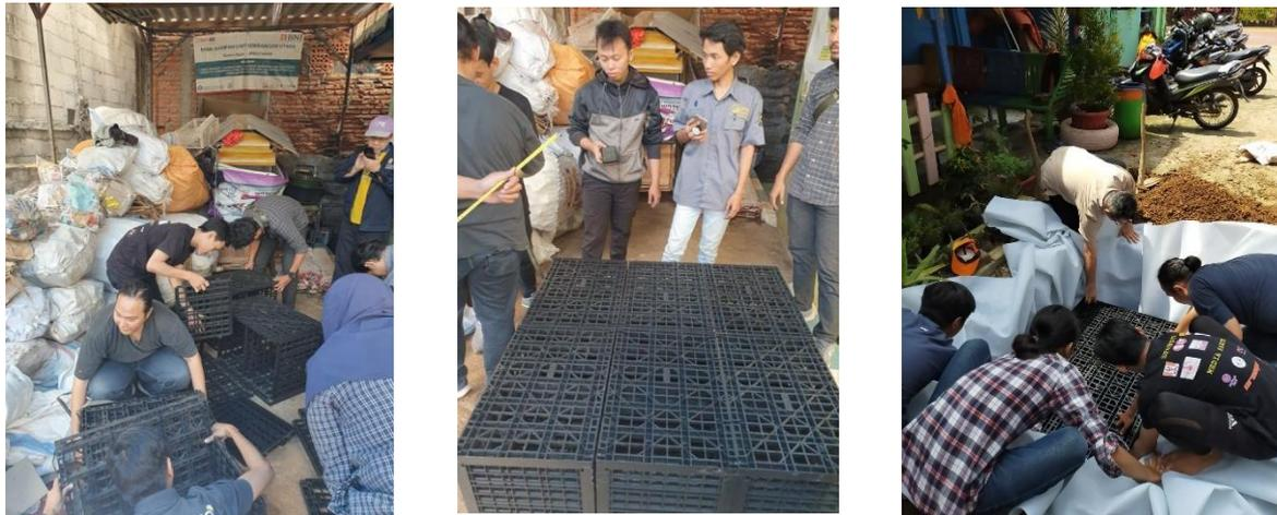
*Gambar 5.* Perakitan dan Pmasangan Modular Tank pada sumur resapan
